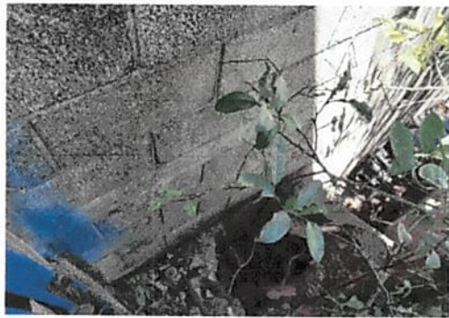
Foto 9: reparación de muro perimetral
