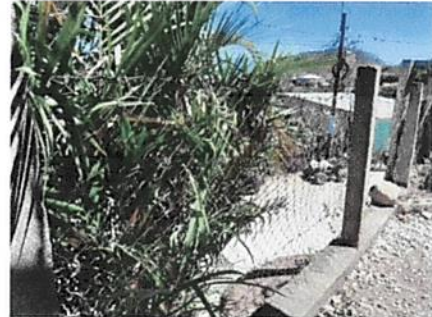
Foto 2: reparacion de muro perimetral (cambio de Maya)
