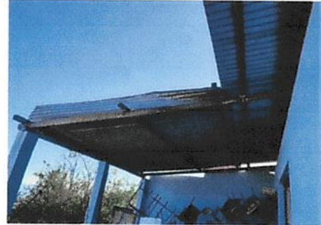
Foto 8: sustitución de techo
