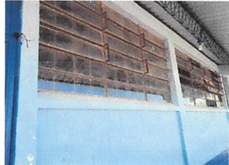
Foto 4: mantenimiento de ventanas
