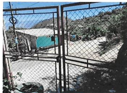
Foto 6: reparación de portón 2 (entrada de rampa)
