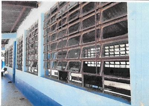
Foto 7: reparación de ventanas
